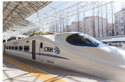
浙江省嘉兴市高铁南站项目
