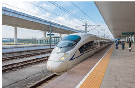
安徽省安庆市高铁西站项目
